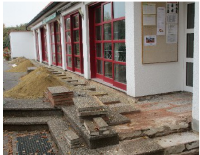
Um das gesamte Vereinsheim herum wird eine Abdichtung gezogen und eine Sockelsanierung durchgeführt, um zukünftig Feuchtigkeitsschäden zu vermeiden.
