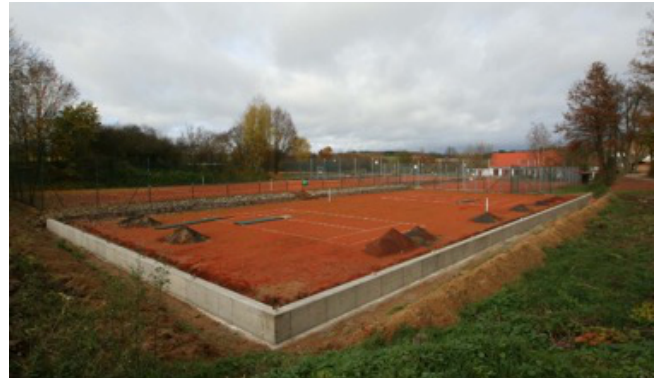
Der Hochwasserschaden an Platz 7 aus dem Jahr 2013 wird ebenfalls in diesem Jahr behoben.
