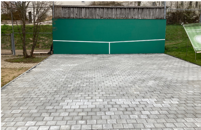
Reparatur und neuer Anstrich der Trainingswand
